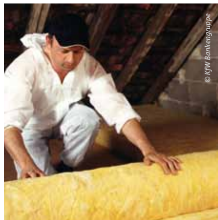
KfW-Zuschüsse für Einzelmaßnahmen begünstigen auch die Wärmedämmung
